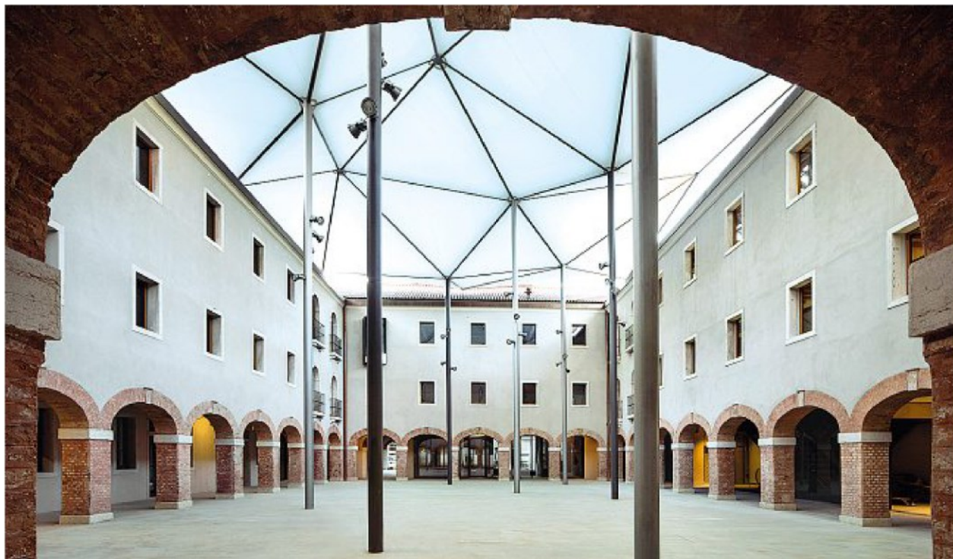
Scorci Vista sulla corte del convento, dove è evidente la copertura studiata per mantenere un microclima adatto alle soste dei cittadini (Fotografie di Alessandra Chemollo © Polymnia Venezia)
